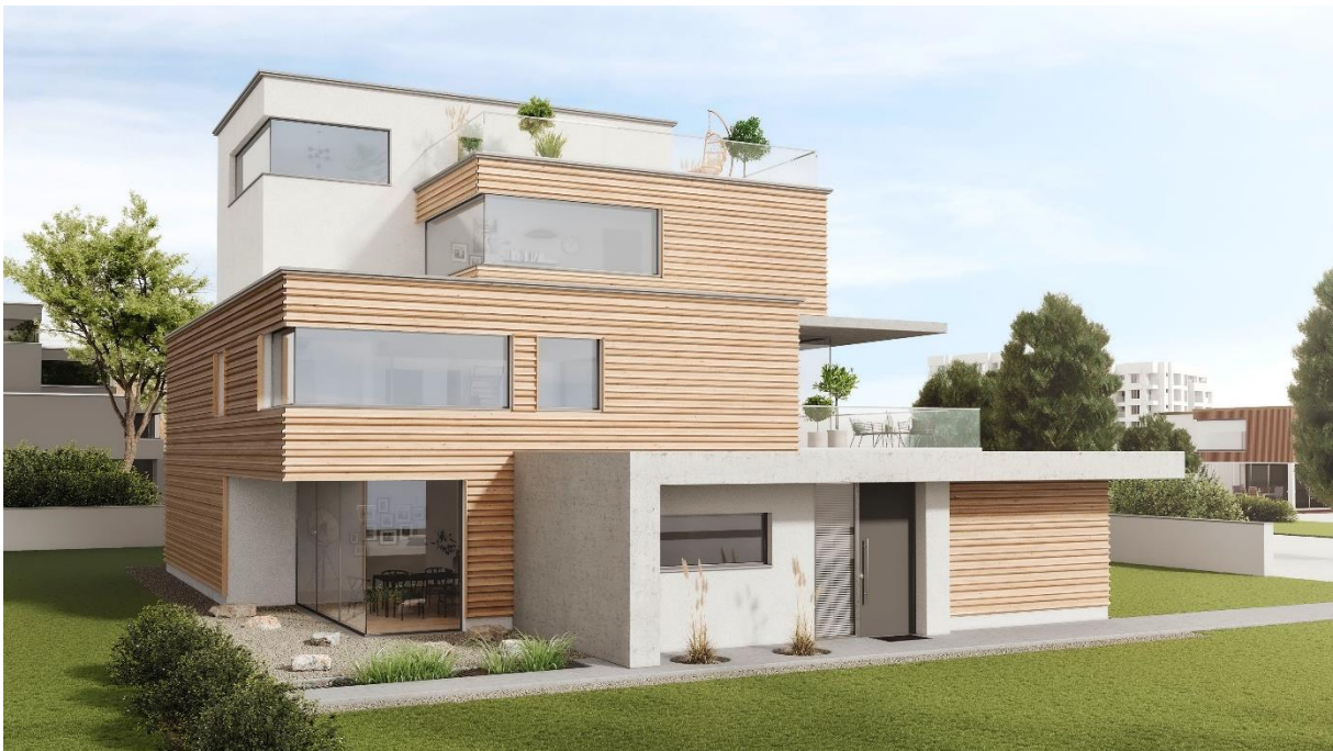
Profilés Pinumont Larixron, modèle de pose horizontal : la façade vit grâce au relief créé par Pinumont. La forme cubique de la construction est élégamment soulignée.
